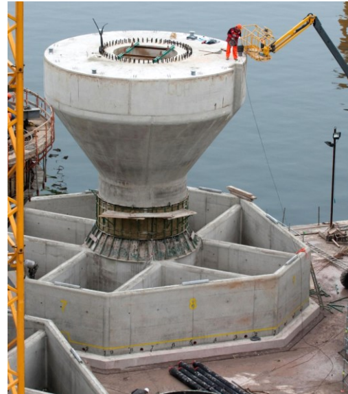
Abbildung 1.1: Filigrane Tragstruktur der Sherbrooke Fußgängerbrücke in Quebec, Kanada, aus vorgespanntem UHPC (links, © DR Médiathèque Lafrage), Schwergewichtsfundament aus vorgespanntem Beton für eine Offshore-Windenergieanlage (rechts, Rainer Kwiotek/© Bilfinger Berger)
