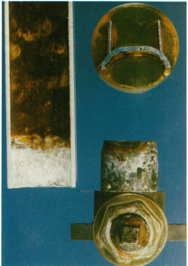
Abb. 7 Spaltkorrosion an Rohrverbindung eines Aluminiumröhrenheizkörpers
