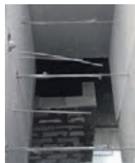
Abb. 3: Blick von oben in den Schlot mit den bidirektionalen Sonden, den Gasnahmesonden und den Thermoelementen
