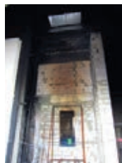
Abb. 2: Blick von der Zuluftöffnung in den Prüfstand auf die Brandraumöffnung
