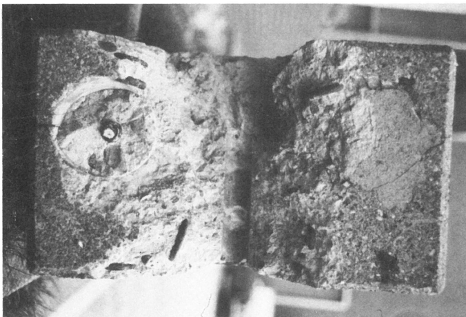
Bild 2.12 Eines der beiden Enden des Spannbetonriegels A3. Stemmstelle im Bereich des Haltedorns. Rechte Ausmörtelung vor der Spannglocke erkennbar
