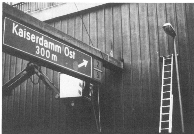
Bild 2.4 Einschneiden eines Fensters in die Spundwand und Abtrennen des Riegels vor dem Auflager
