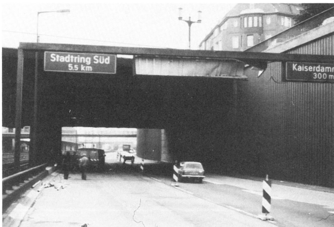
Bild 2.1 Verkehrszeichenbrücke im Bereich des Stadtringes Süd. Spannbetonriegel A1 vor der Entnahme
