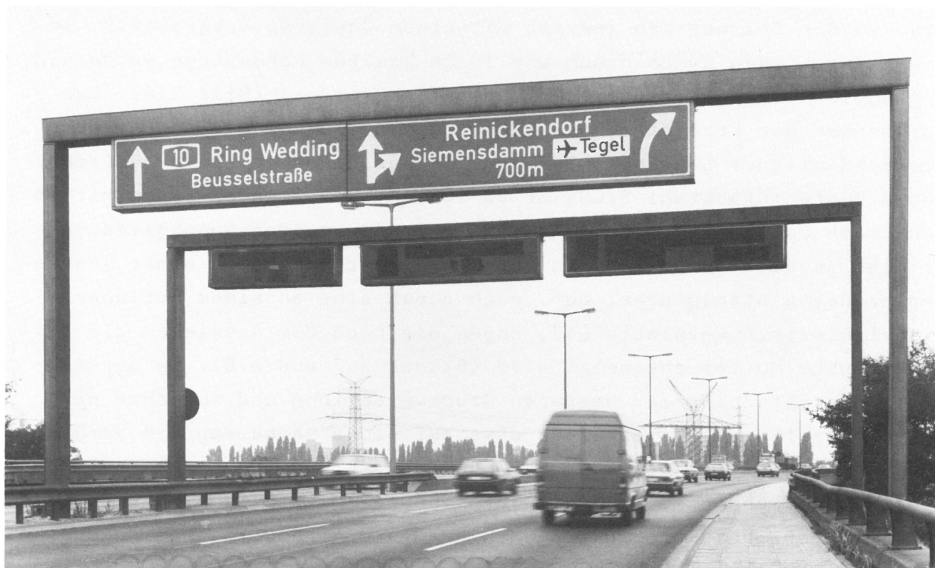
Bild 2.5 Verkehrszeichenbrücken im Bereich des Berliner Stadtautobahnringes Nord. Spannbetonriegel A3 mit bereits unkenntlich gemachten Hinweistafeln vor der Entnahme; im Vordergrund neu aufgestellte Brücke in Stahlbauweise
