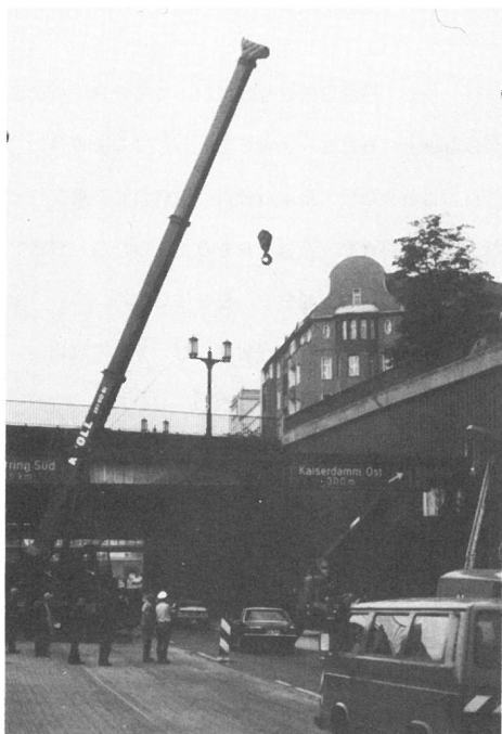
Bild 2.3 Abbau der Verkehrszeichenbrücke - der Riegel bindet auf der rechten Seite in nicht erkennbarer Weise in die Kasten- spundwand ein
