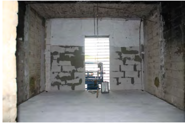
Abbildung C.25: Brandraum: Blick in Richtung Brandraumöffnung
