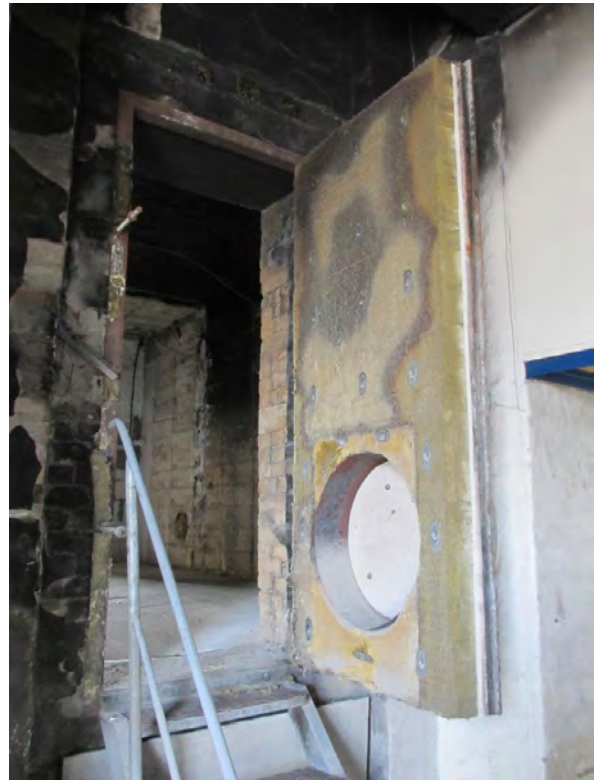
Abbildung C.22: Brandraum: rückseitige Zugangstür
