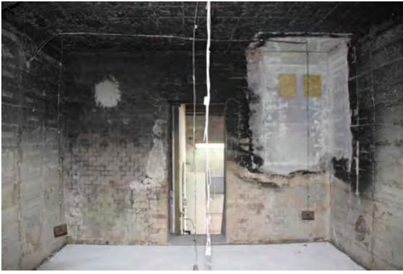
Abbildung C.24: Brandraum: Blick in Richtung Zugangstür
