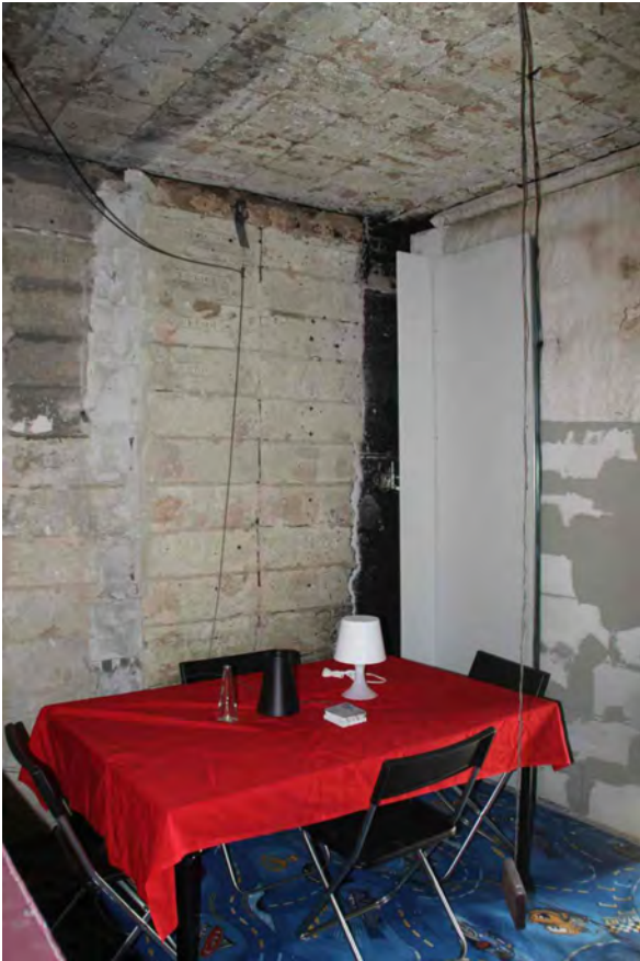
Abbildung C.26: Esstisch im Brandraum mit Vergleichsgegenständen und Tischdecke (im Hintergrund Tapetenelement 2)
