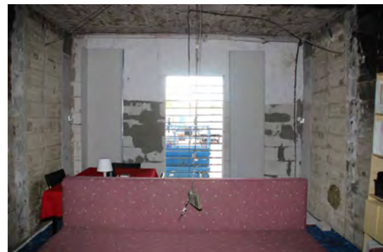
(c) Blick durch die Zugangstür
