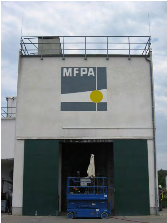
Abbildung C.21: Versuchsgebäude (Außenansicht), Zulufttor geöffnet, das Podest für die Kameras K3 und K4 befindet sich vor dem Tor
