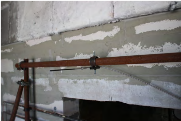
Abbildung C.44: Messstelle G5 am Gerüst über der Brandraumöffnung
