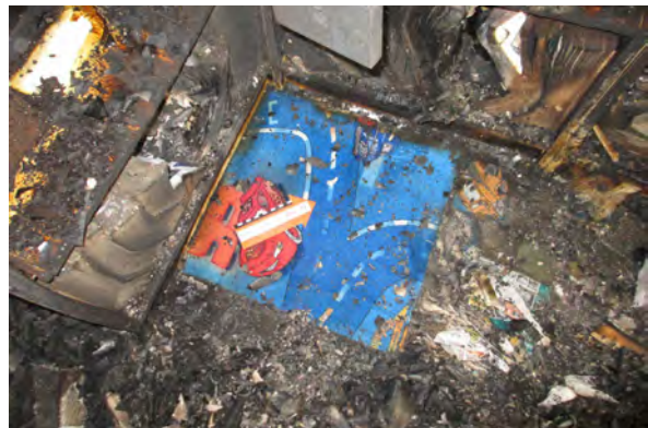
Abbildung C.70: MFPA_Zimmer_005: Teppichboden in der Regalecke nach dem Versuch, Teppichelement entfernt
