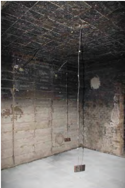
Abbildung 2.6: Vertikale Temperaturmessstellen T5 und T6 im Brandraum
