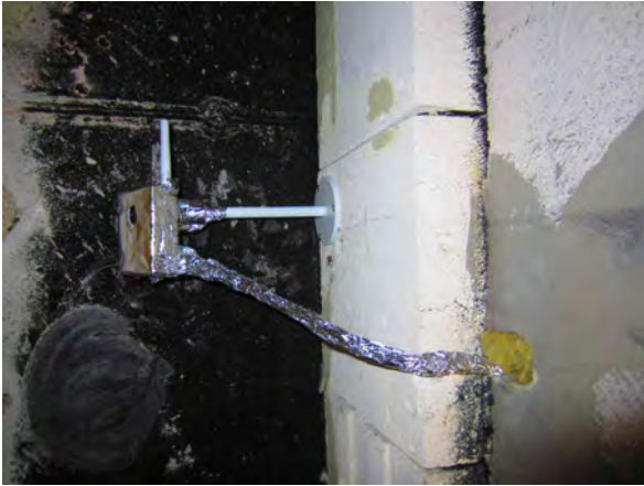
Abbildung C.38: Kamera K2 mit Aluminiumverkleidung vor Montage des Tapetenelements
