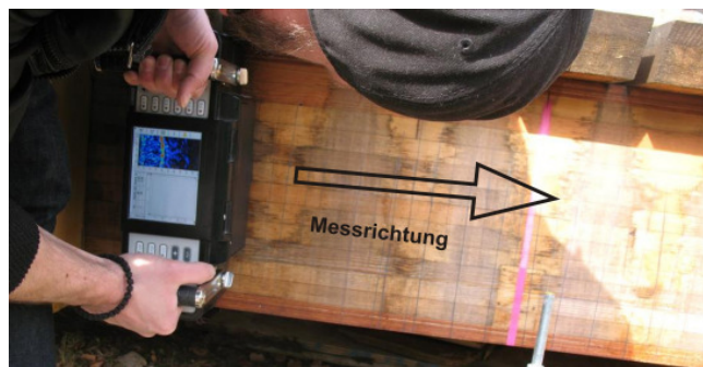
Bild 7 Messung mit dem Linearen Array (Scherwellen) an Fußgängerbrücke aus Sibirischer Lärche, Messrichtung ~ Polarisation ~ Faserrichtung L, (siehe Kapitel 4.2).
