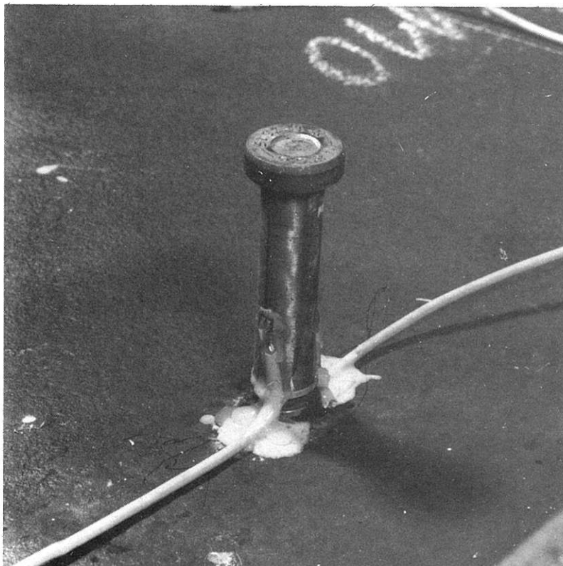
Bild 34: Kopfbolzendübel mit DMS unter Schutzschicht
