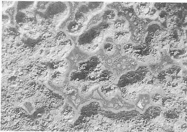
Abb. 67: wie Abb. 66, jedoch nach Entfernung der Korrosionskruste mit Ionenaustauscherkompressen
