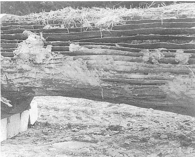
Abb. 63 Ansicht abgeplattete Kühlrippen
