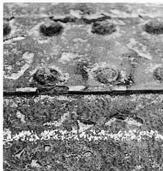
Bild 2: Buckelblech mit Schäden infolge Korrosion und Reibung durch das Schotterbett
