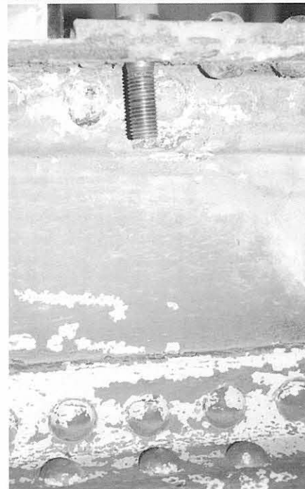
Bild 29: Sitz der Schraube M20 vor dem Ausbohren der Nietlöcher
