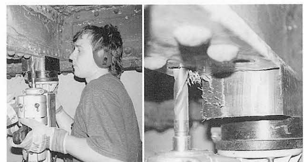
Bild 30: Ausbohren der Nietlöcher mit einer Magnetbohrmaschine
