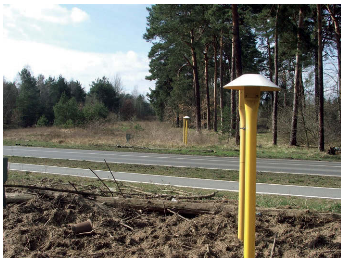
Abb. 1: Trassenmarkierung einer Erdgaspipeline bei Unterquerung einer Straße
