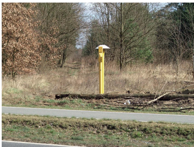
Abb. 2: Trassenpfosten in einem Waldgebiet
