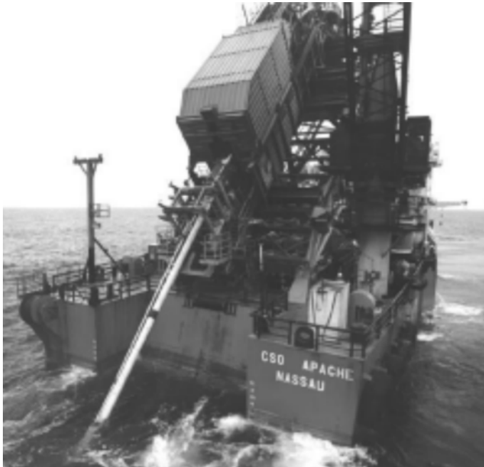
Bild 1.2: Verlegung einer Offshore-Pipeline von einem Verleges Schiff (Lay Barge) [2]
