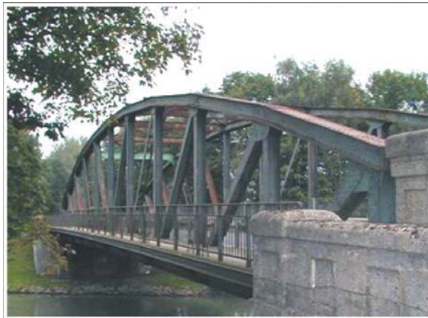
Bild 6–9: Tragwerk aus Flusstahl über den Mittellandkanal
