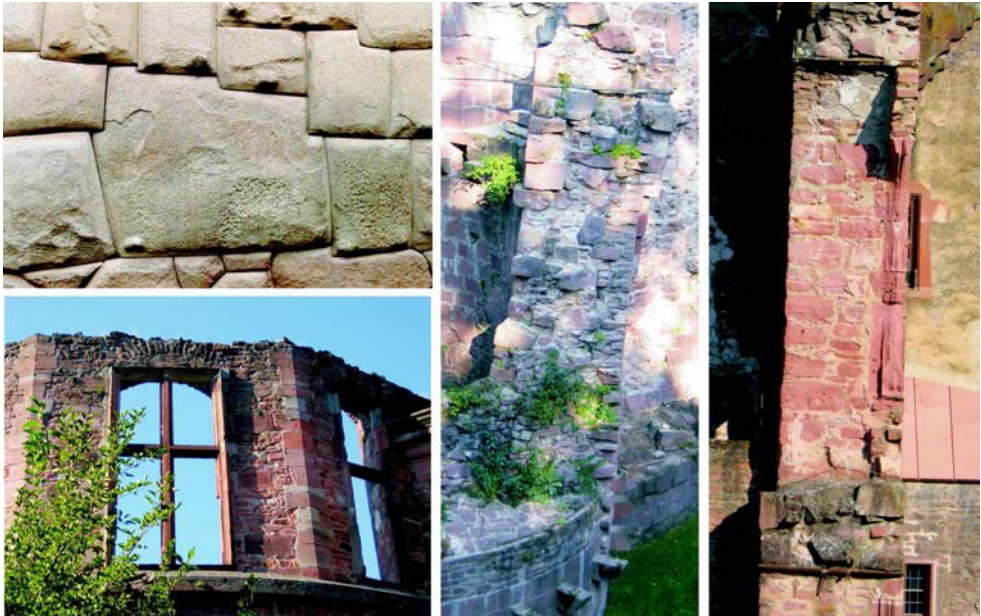
Abbildung 8.2: Beispiele für unterschiedliche Ausführungen von historischem Mauerwerk
