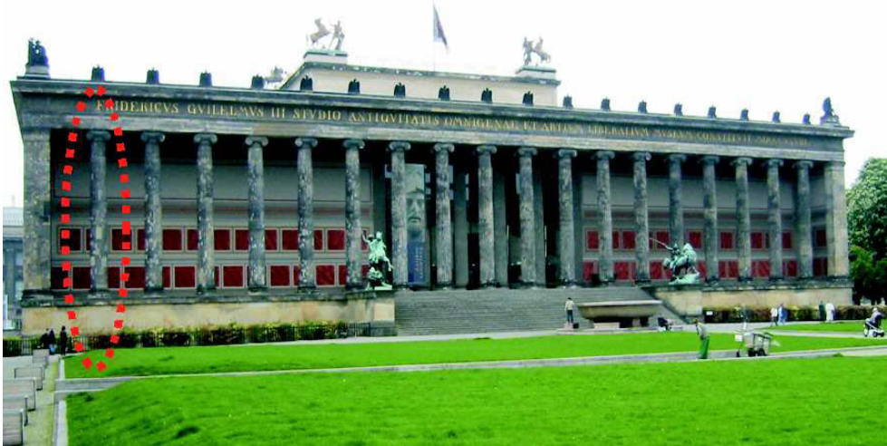
Abbildung 8.6: Ansicht des Alten Museums mit Angabe der untersuchten Sandsteinsäule
