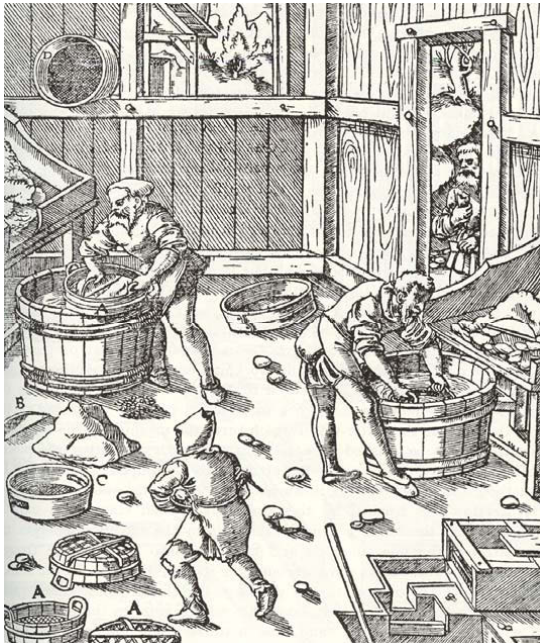
Abbildung 2.4: Handsetzarbeit mit Stauchsieben in der Erzaufbereitung im 16. Jahrhundert [157]
