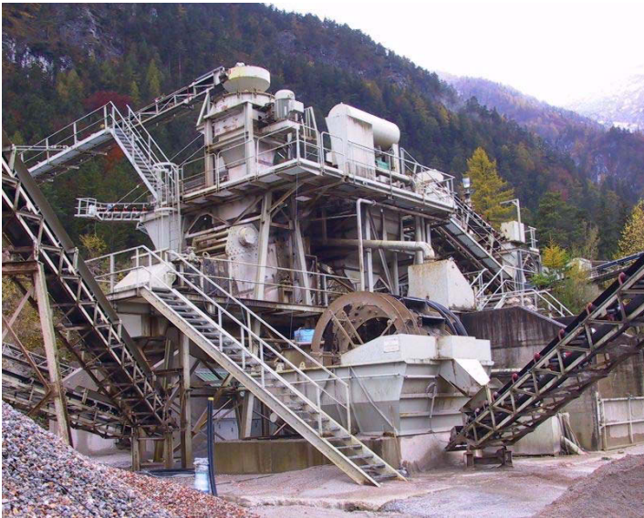
Abbildung 2.7: Aufbereitungsanlage für mineralische Rohstoffe und Bauschutt in Hallein, Österreich
