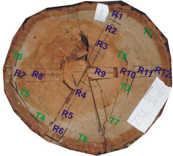
Abbildung 6.10: Eiche Nr. 1 - Pilzbefall: Foto von Messebene 2 mit Kennzeichnung der entnommenen Probe Segmente für die Labormessungen. Die durch den Pilz verursachte Kernholzverfärbung ist deutlich erkennbar.
