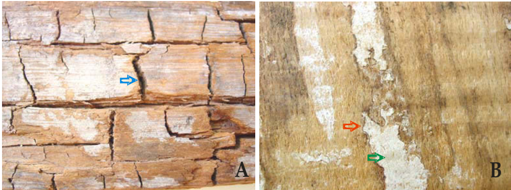
Abbildung 1: A Von einem Braunfäulepilz befallener Holzprüfkörper (Nadelholz). Der blaue Pfeil zeigt die für diesen Befallstyp charakteristischen „Würfelbruch“. B Ein mit einem Weißfäule erregenden Pilz befallenes Laubholzstück. Roter Pfeil: Demarkationslinie. Grüner Pfeil: weiße Zellulosefasern. ein typisches Schadbild das durch Weißfäule erregende Pilze hervorgerufen wird.
