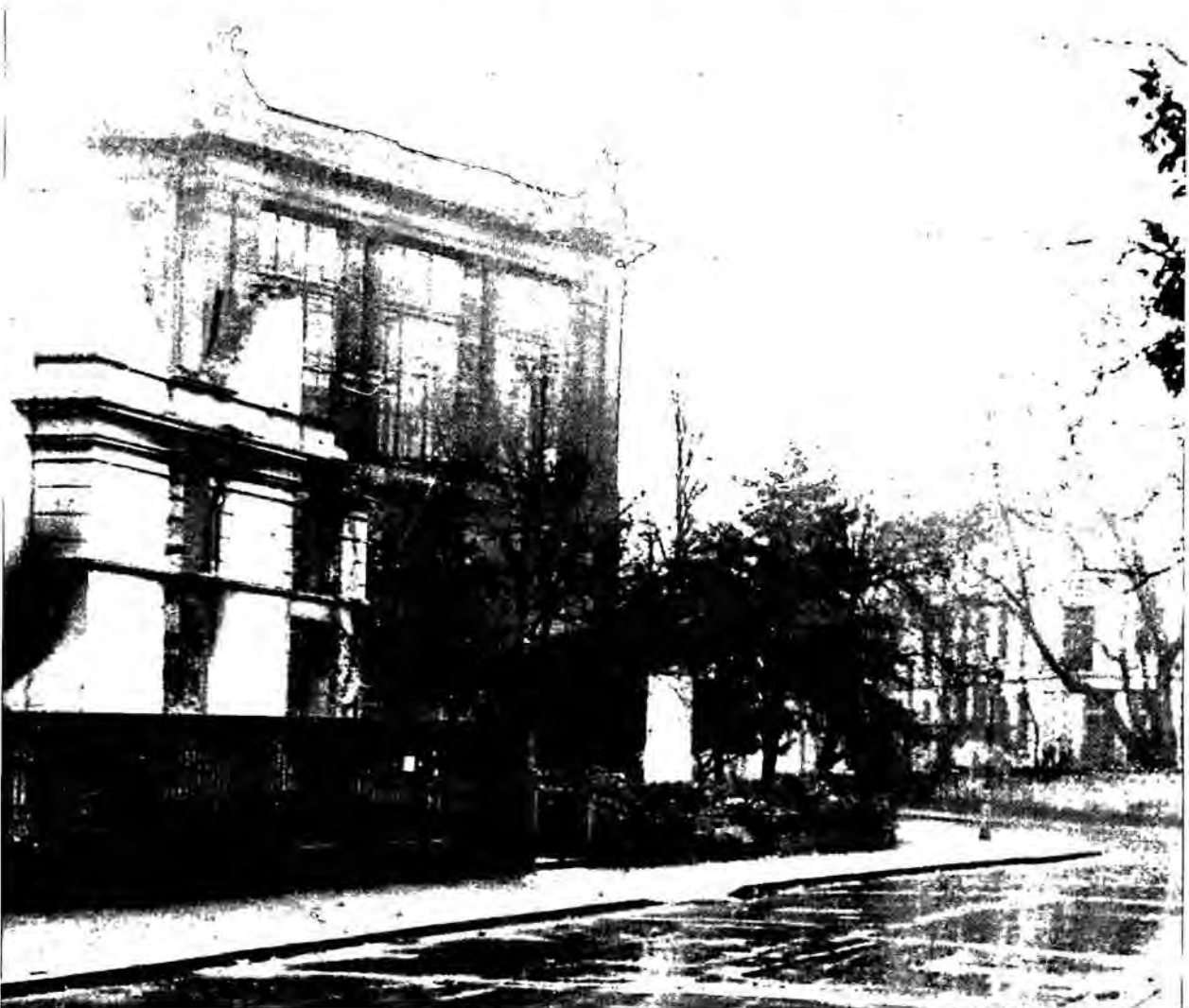
Die zerstörte Wöhlerschule 1944
