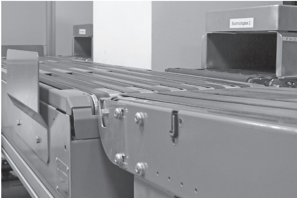
Abb. 3: Zusätzliche manuelle Zuführung von Medien an der Anlage im Jacob-und-Wilhelm-Grimm-Zentrum
