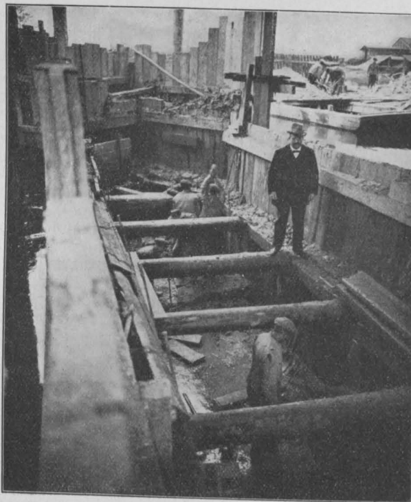
Abbildung 4. Abbruch eines Pfeilerfundamentes.
