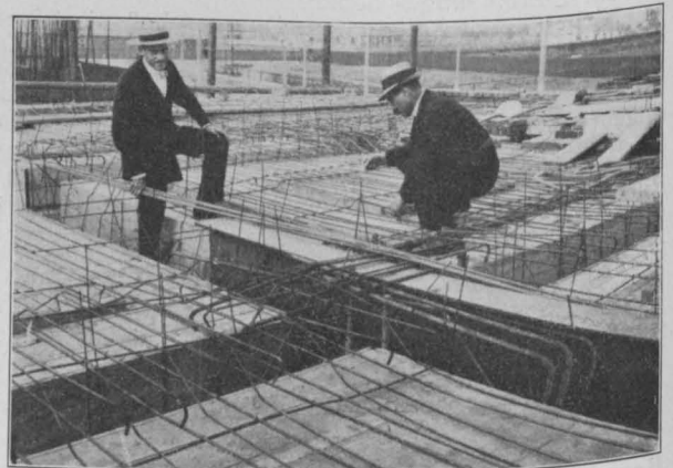
Abbildung 3. Mit I-Trägern N. P. 55 verstärkter Unterzug.
