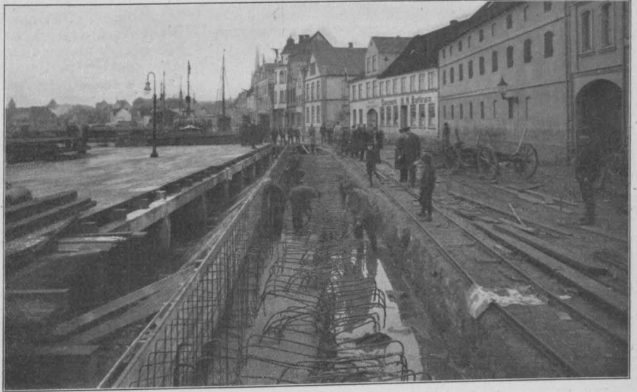
Abbildung 15. Ufermauer in Sonderburg im Bau.
