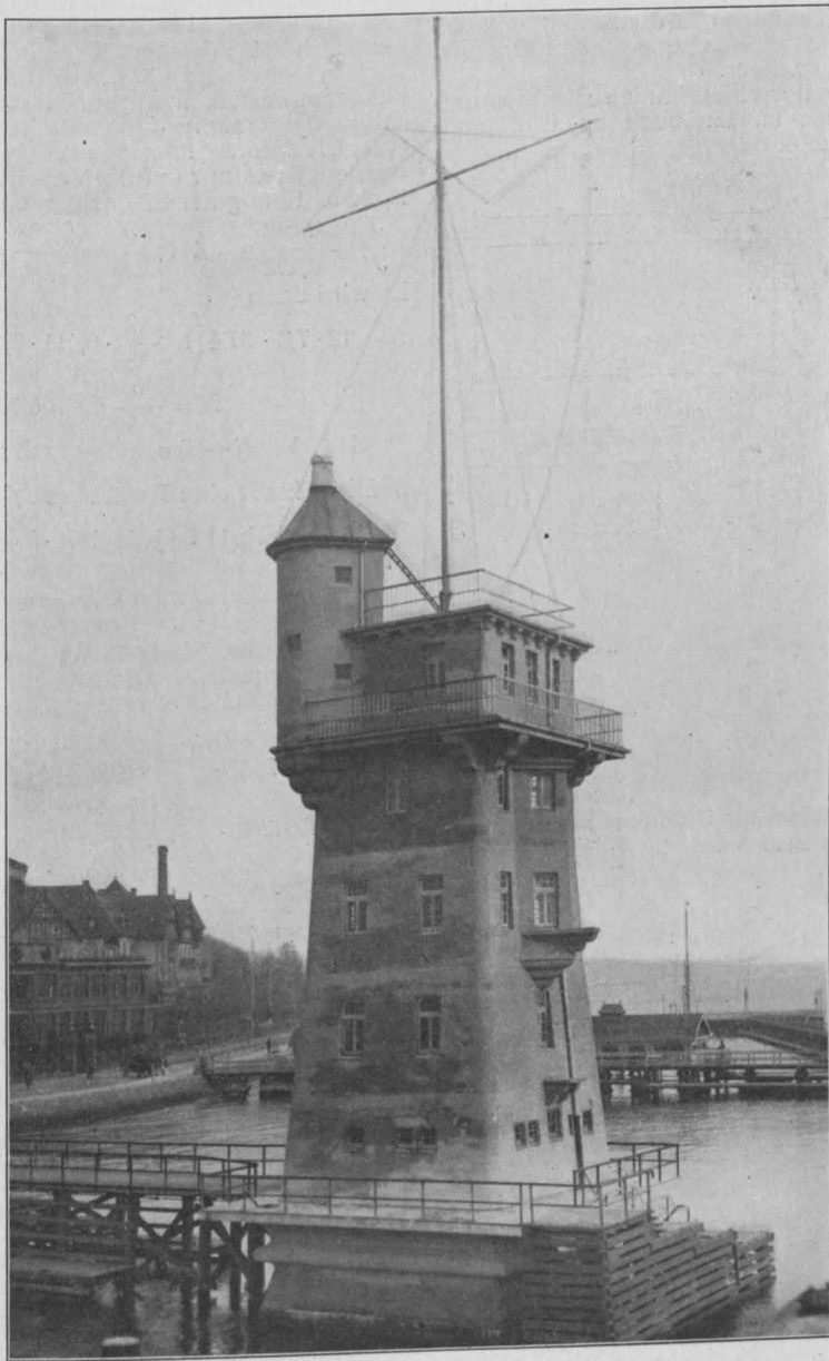
Beobachtungs- und Signalturm im Hafen zu Kiel. Abb. 14. Fertiger Turm.
