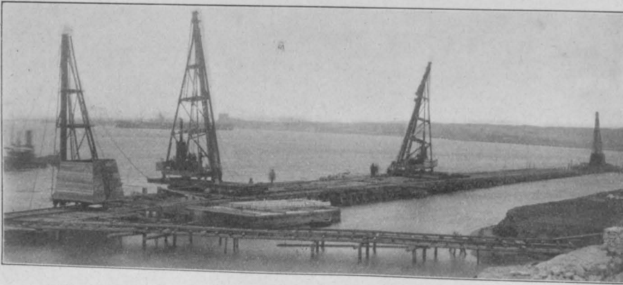
Abbildung 20. Herstellung einer Eisenbeton-Kaimauer; Hafen von Nikolajew.
