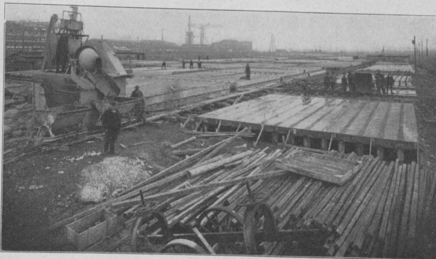
Abbildung 5. Herstellung der Betonpfähle. Kaimauer am Roß-Kanal in Hamburg.
