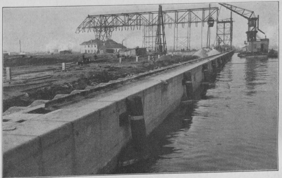
Abbildung 17. Fertige Kaimauer in Stettin.
