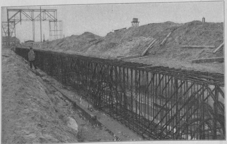
Abbildung 18. Eisenbewehrung des Kranbalkens in Abb. 17 (60 t Raddruck).
