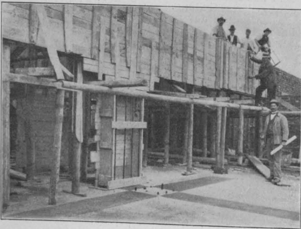
Abbildung 9. Gegen das Untergeschoß versetzte Stütze der Grenzwall.
