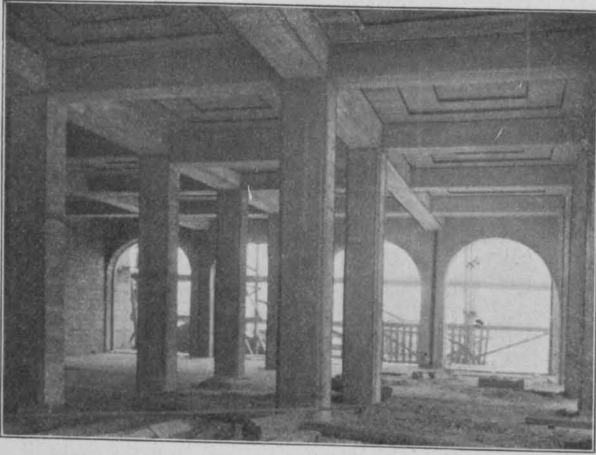
Abbildung 2. Stützenstellung und Deckenteilung im Erdgeschoß.
